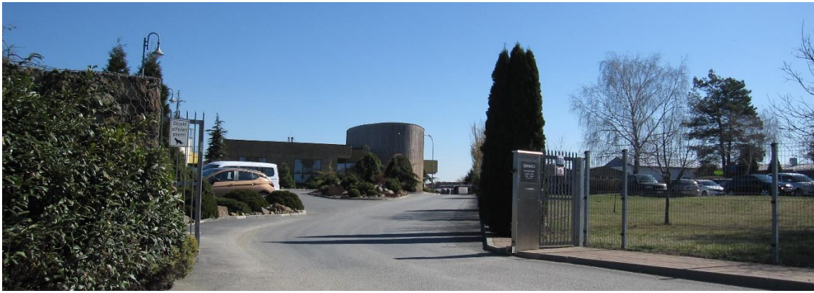
7. Bohunická cesta – vjezd do areálu firmy ZEMAKO s.r.o
