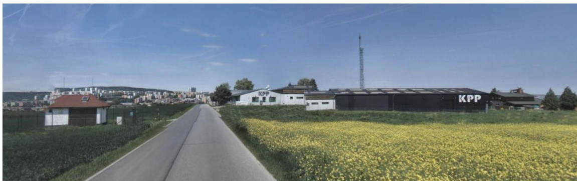
2. Bohunická cesta - příjezd do výrobní zóny z jihu (u regulační stanice VTL/STL)
