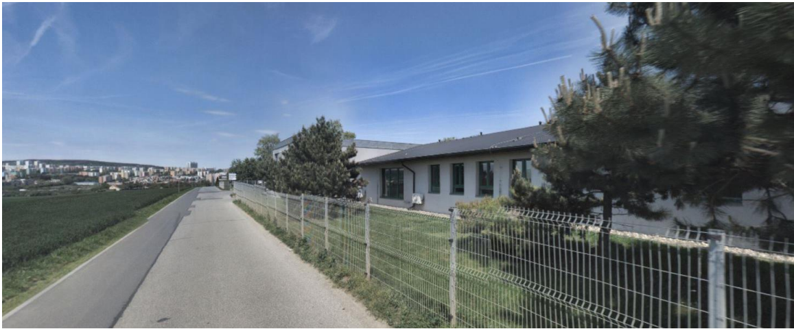
5. Bohunická cesta – vedení komunikace vedle areálu firmy KPP s.r.o.
