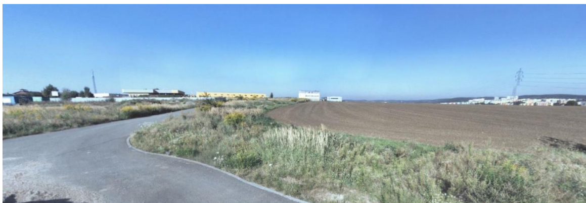
15. Bohunická cesta – dopravní koridor pro napojení výrobních ploch (pohled od východu z obratiště)
