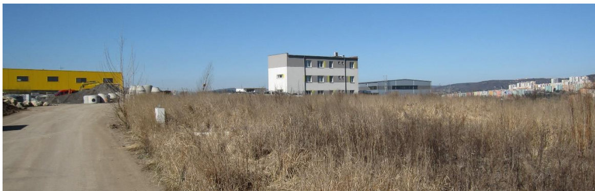
16. Bohunická cesta – dopravní koridor pro napojení výrobních ploch (pohled od východu)
