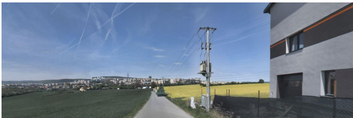
11. Bohunická cesta – pokračování komunikace severním směrem (u sloupové elektro stanice)
