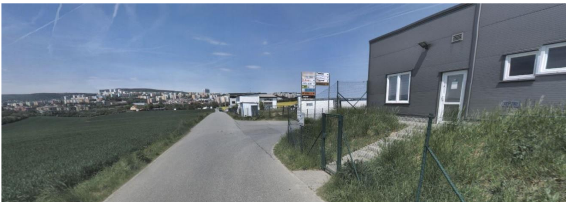
9. Bohunická cesta – vedení komunikace před napojením do střední části výrobní zóny
