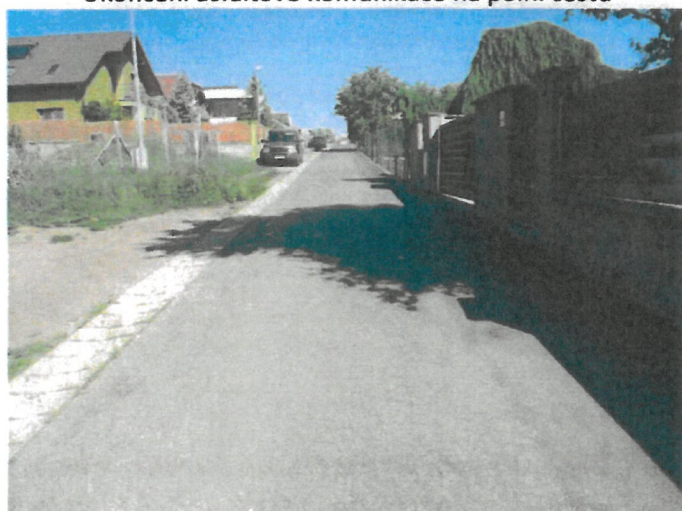
Část ulice Za Humny, po stranách odvodňovací tvárnice
