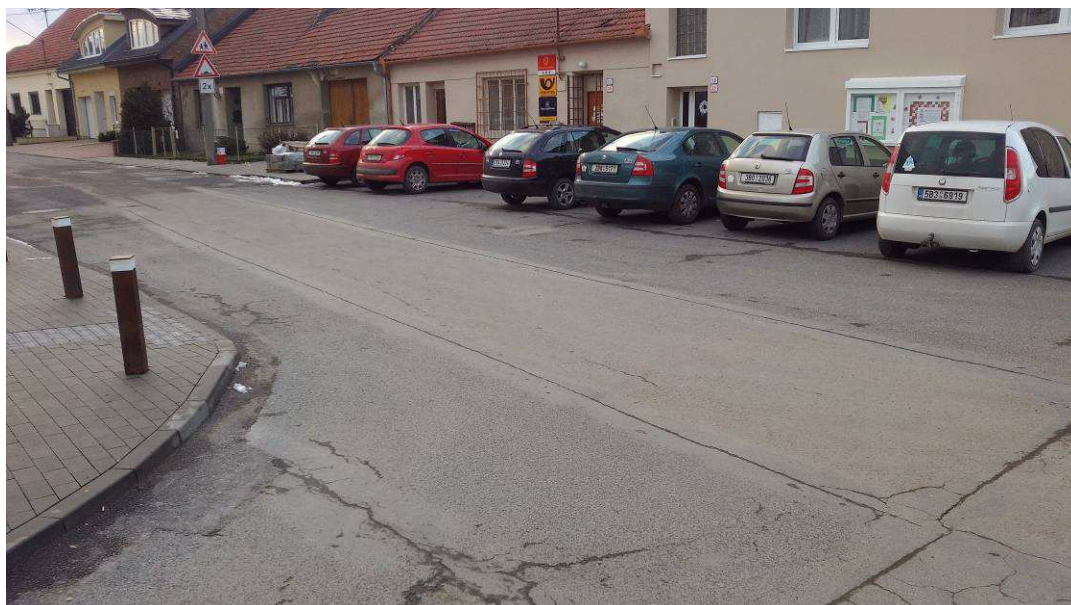
Podélné trhliny na pracovních spárách, mozaikové trhliny (ul. Střední)
