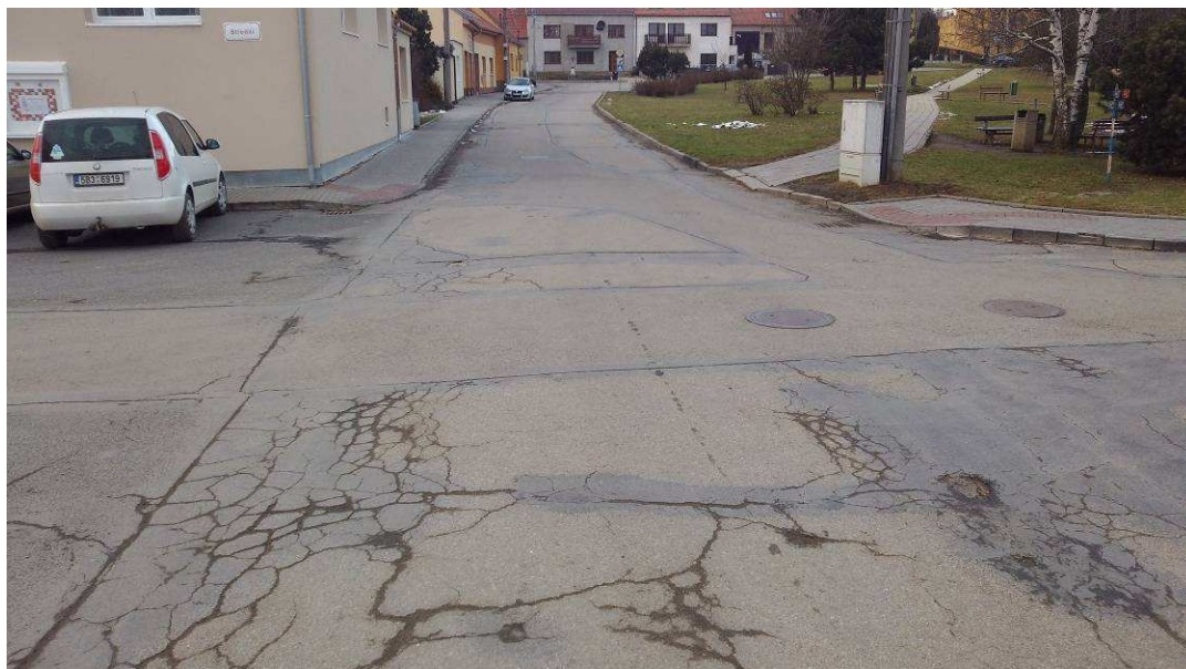
Trhliny na pracovních spárách, mozaikové trhliny, výtluky, vysprávký tryskovou metodou (křižovatka ul. Vnitřní s ul. Střední)
