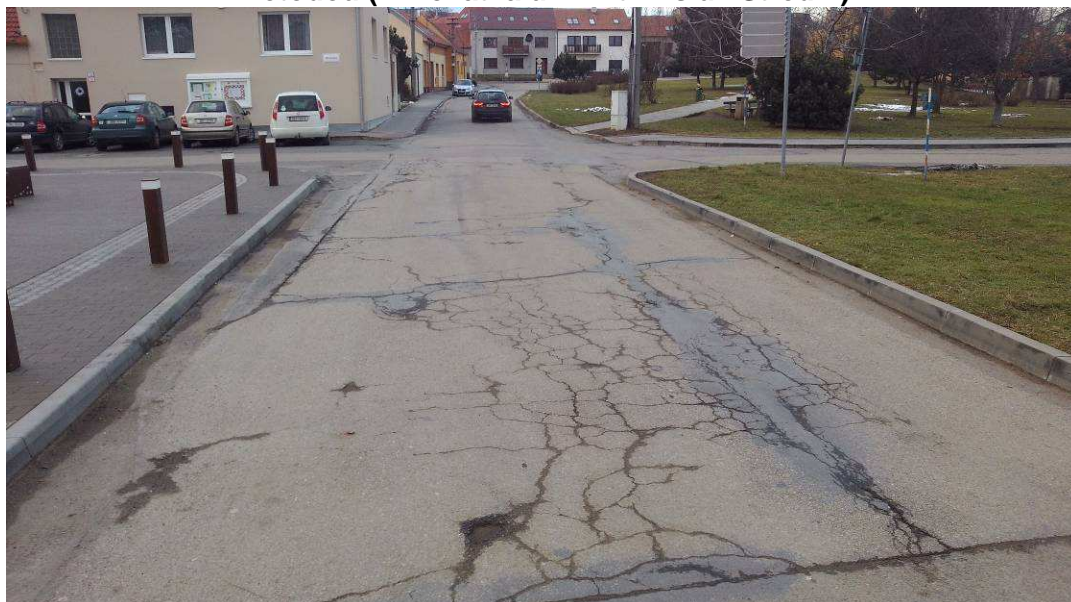
Příčné trhliny, mozaikové trhliny, výtluk, vysprávký tryskovou metodou (ul. Vnitřní)
