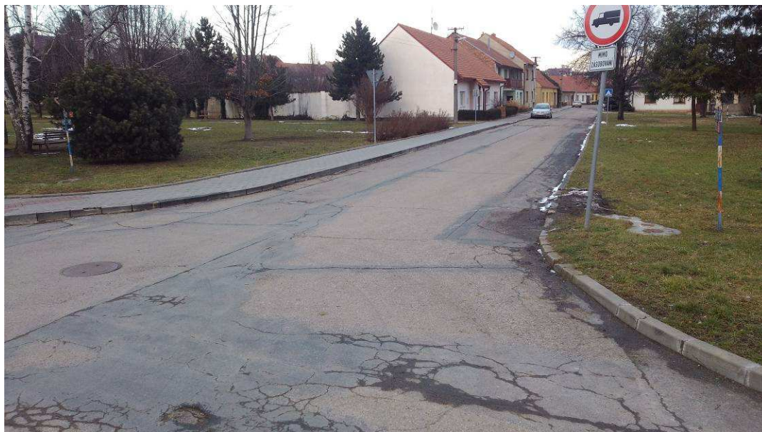
Podélné trhliny, mozaikové trhliny, výtluky, vysprávký (ul. Střední)
