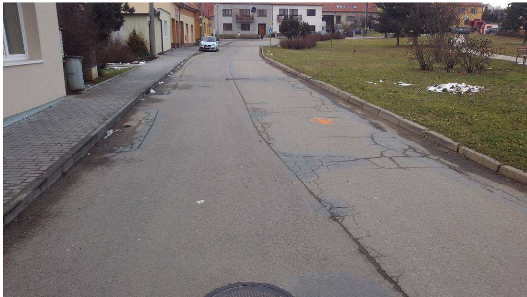
Pohled na začátek úseku, podélná široká trhлина, mozaikové trhliny (ul. Vnitřní)
