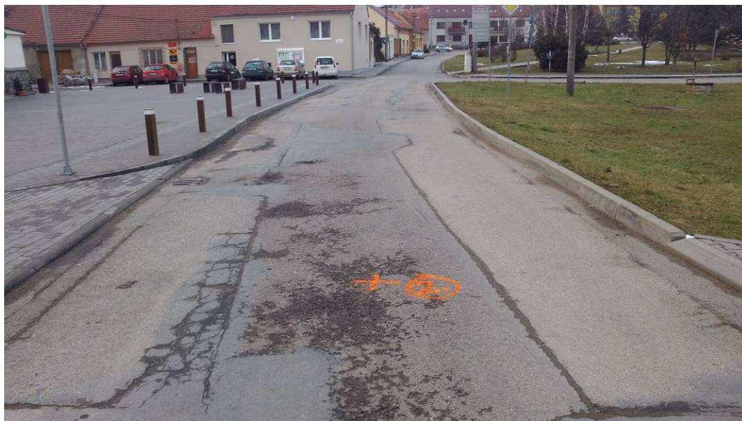
Podélné trhliny na pracovních spárách, mozaikové trhliny, hloubková koroze (ul. Vnitřní)
