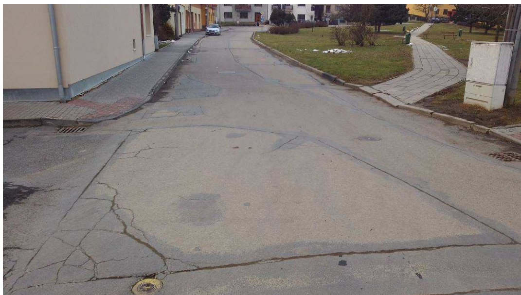
Mozaikové trhliny, trhliny na pracovní spáře, vysprávky (ul. Vnitřní)
