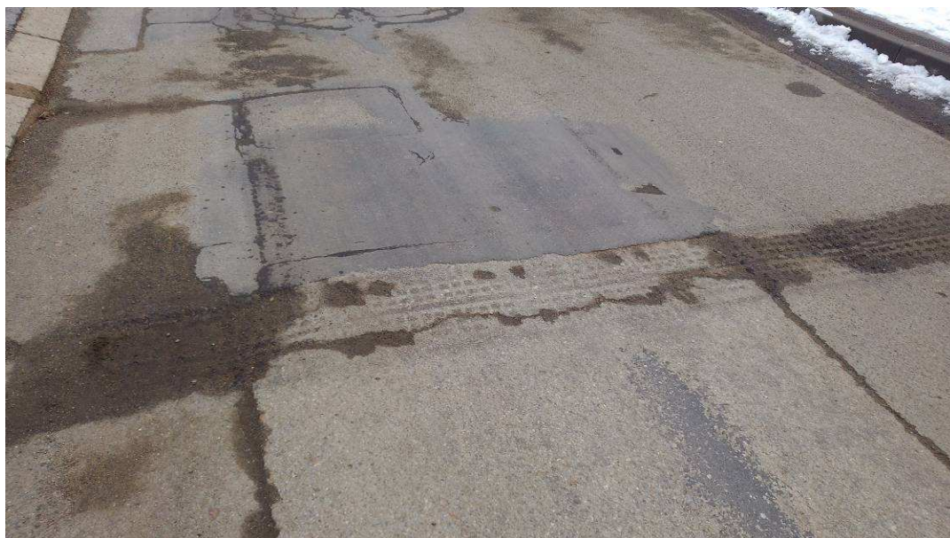
Vysprávka, příčná trhlina, podélné trhliny na pracovních spárách (ul. Vnitřní)
