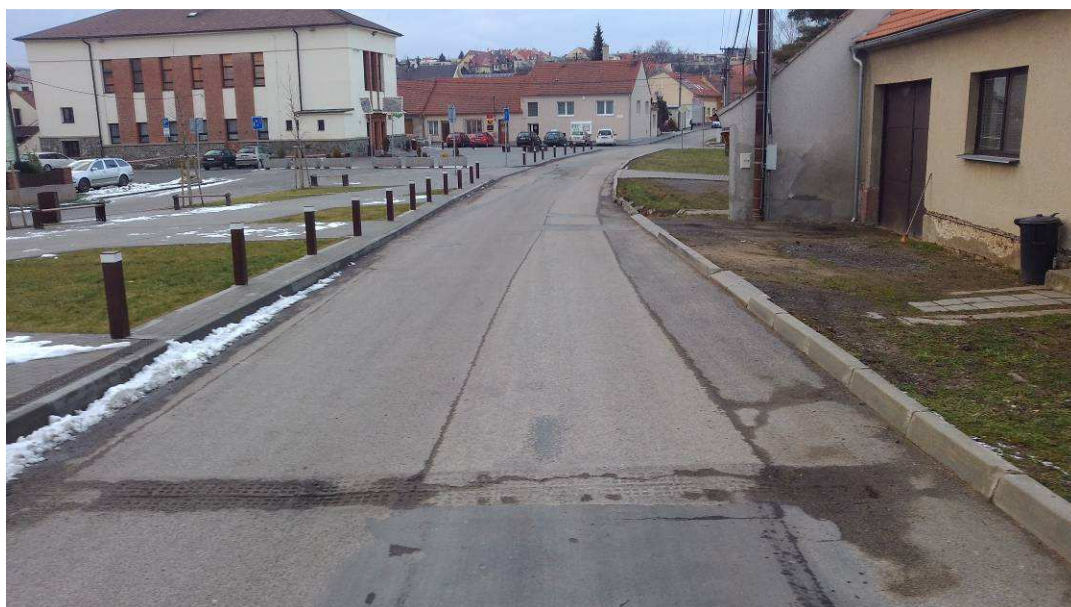
Podélné trhliny na pracovních spárách (ul. Vnitřní)
